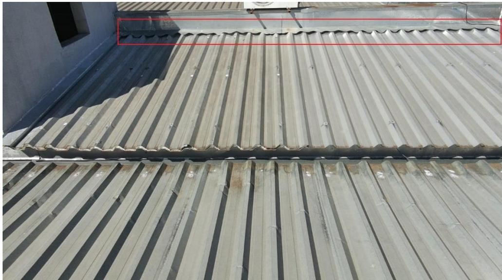
Foto 10 – Rufo com corte no formato do telhado antigo.
