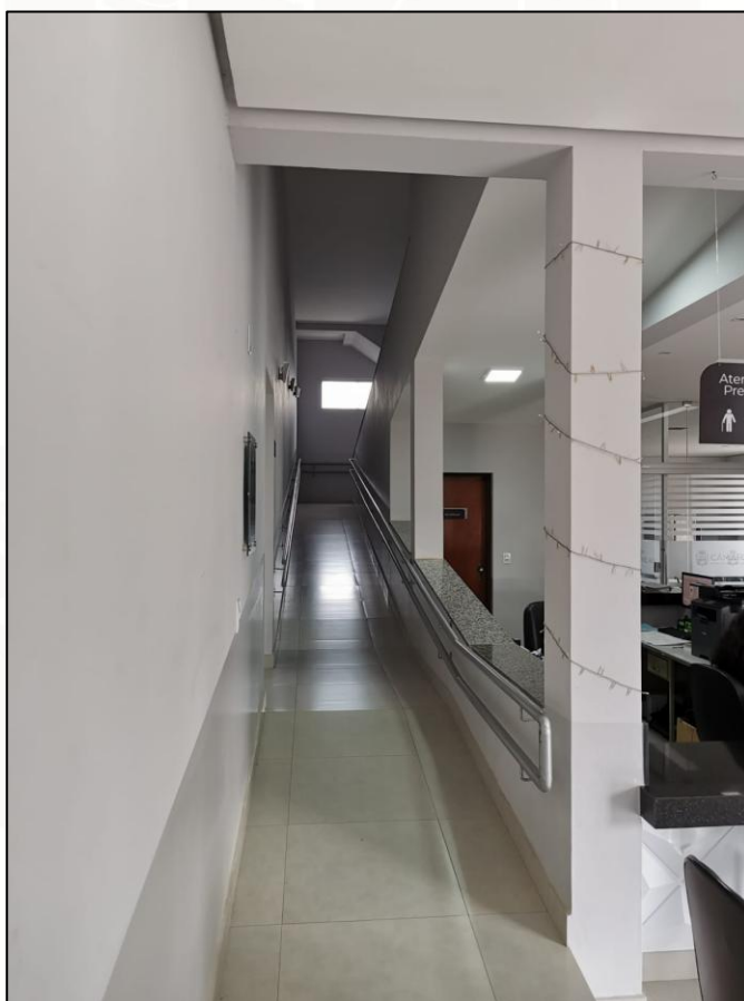
Foto 1 – Local de instalação da porta de vidro de 10mm
