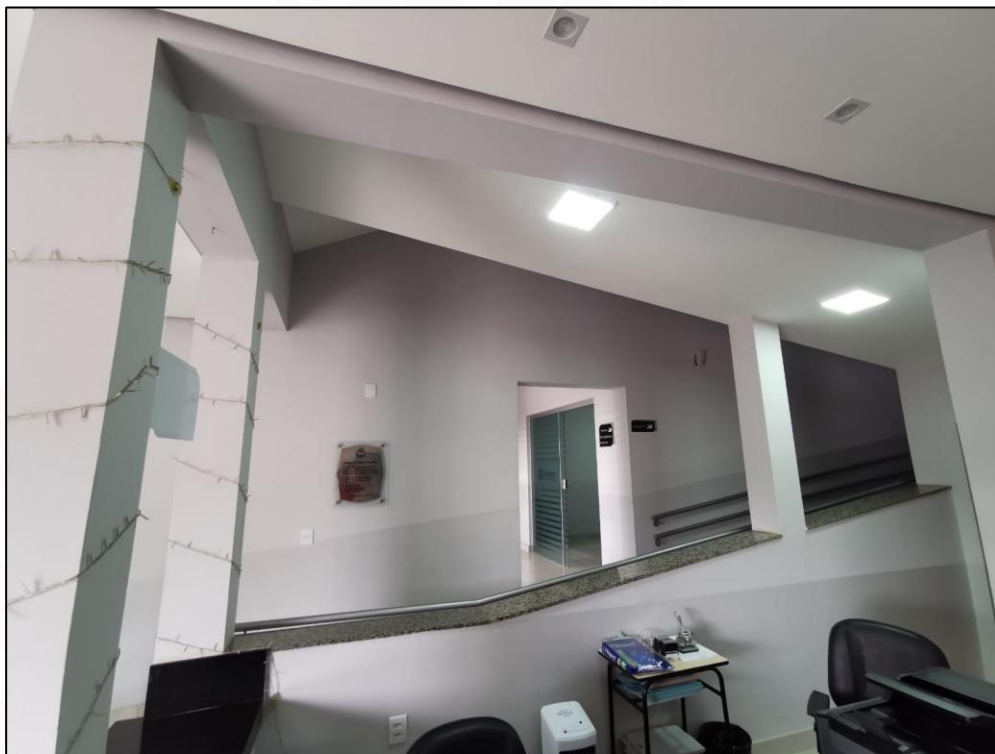
Foto 2 – Local de instalação do fechamento em vidro de 8mm
